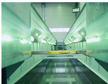
Устройство безопасности в яме
