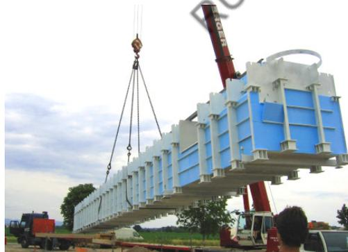
*Комплексная яма* · готовая предсобранный яма для ремонта и визуального осмотра · длиной до 28м · 30 и 60 тонн нагрузки или специальное исполнение · Интеграция всех необходимых компонент для автомастерской, таких как, маслораздача, емкости для слива, гаражного оборудования NUSSBAUM.
