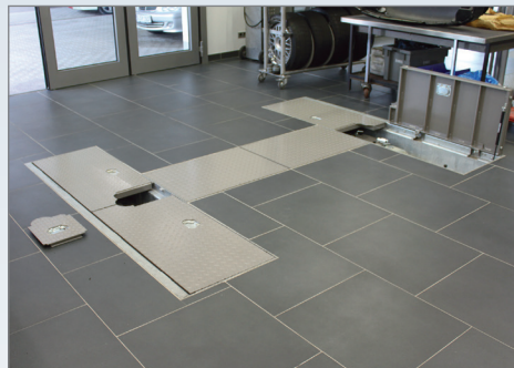
Система с пневмоамортизаторами обеспечивает легкое открывание и закрывание крышек.
