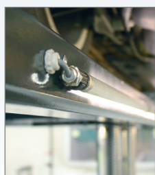
Поворотные светодиодные лампы: простая и быстрая настройка направления освещения, без ослепления находящихся под автомобилем людей.
