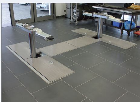
Рамная система с закрывающимися пластинами полностью гальванизирована
